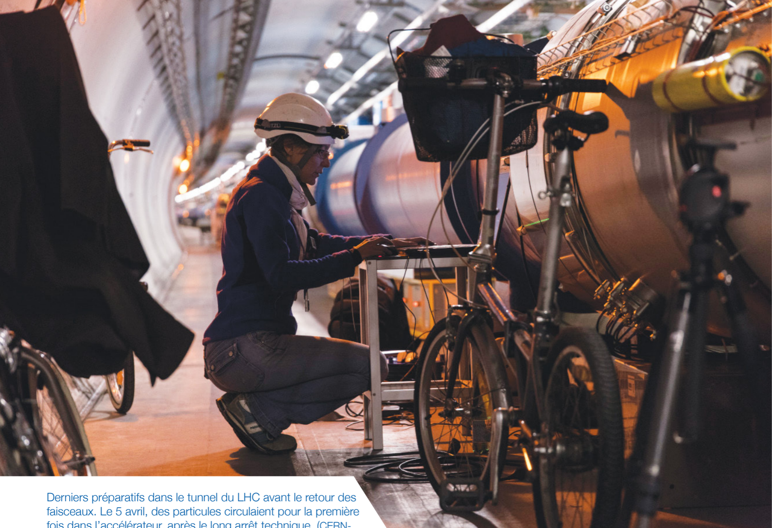
Préparation de l'un des deux nouveaux absorbeurs de faisceaux à l'injection installés pendant l'arrêt technique hivernal des accélérateurs. (CERN-PHOTO-201601-004-8)
