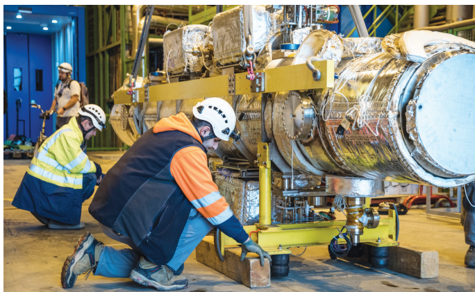
Préparation de l'un des deux nouveaux absorbeurs de faisceaux à l'injection installés pendant l'arrêt technique hivernal des accélérateurs. (CERN-PHOTO-201601-004-8)
