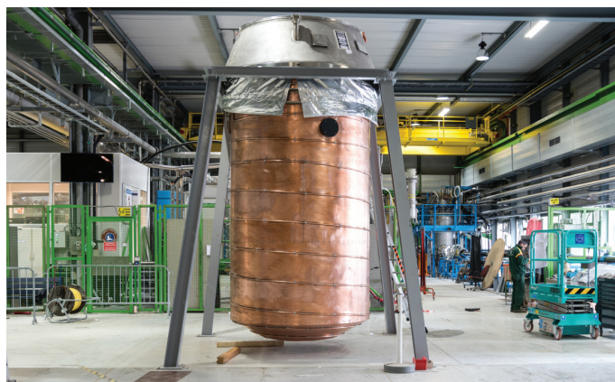
Dans le hall d'essai SM18, un nouveau cryostat destiné à tester des aimants du futur est en cours d'installation. (CERN-PHOTO-201603-062-1)
