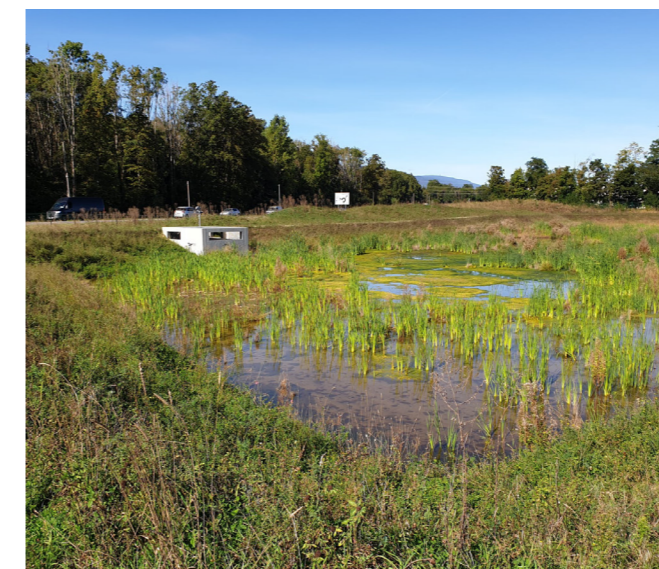
Bassin de rétention recevant les eaux de pluie du site de Prévessin du CERN, et permettant la régulation des rejets dans le Lion et la rétention de toute pollution accidentelle.
