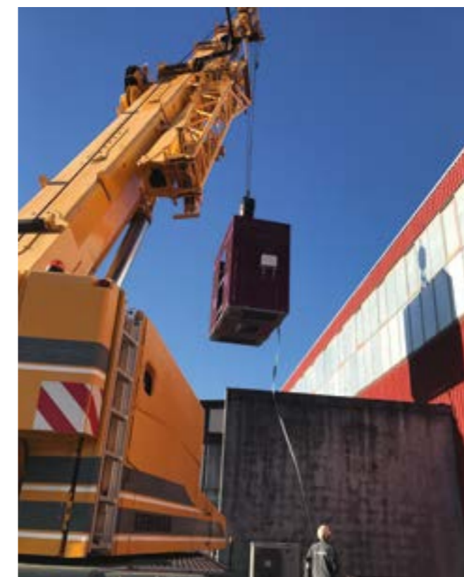
Installation d'un transformateur sec
